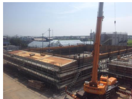
【音楽室から見た体育館建設の様子】
